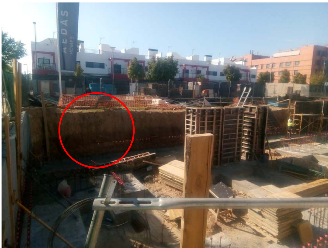
Fotografía 2. Excavación abierta en solar cercano. Ausencia de agua en las paredes.
